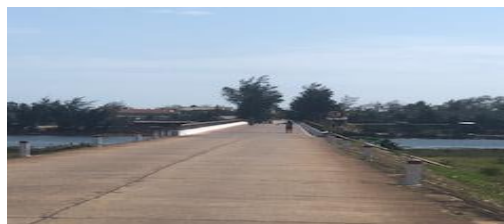
Sông Hà Thanh nơi sẽ xây dựng cầu mới cạnh cầu hiện hữu
